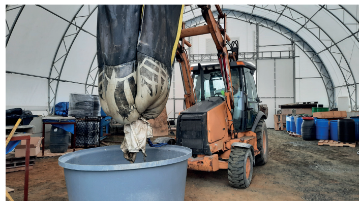
Déshydratation des boues dans un Géotube (Bishop)
