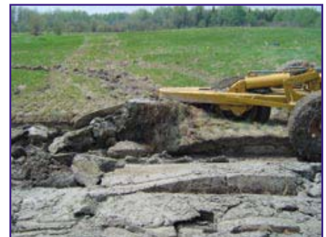
Préparation de terrain.
